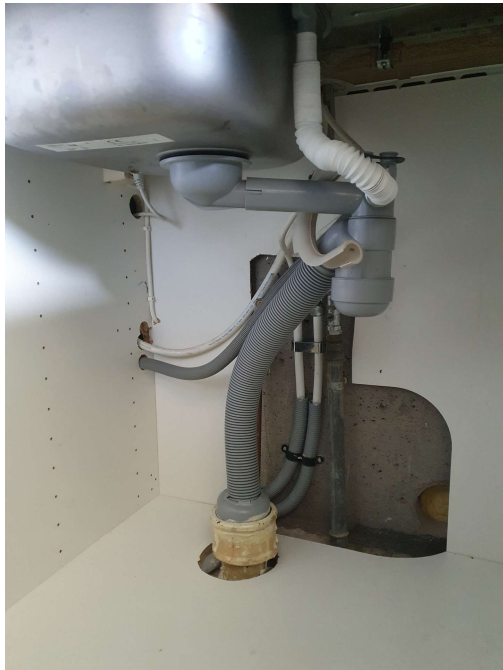
Byte avloppsrör i diskbänkskåp.
