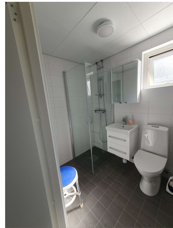
Exempel på renoverat wc/bad
